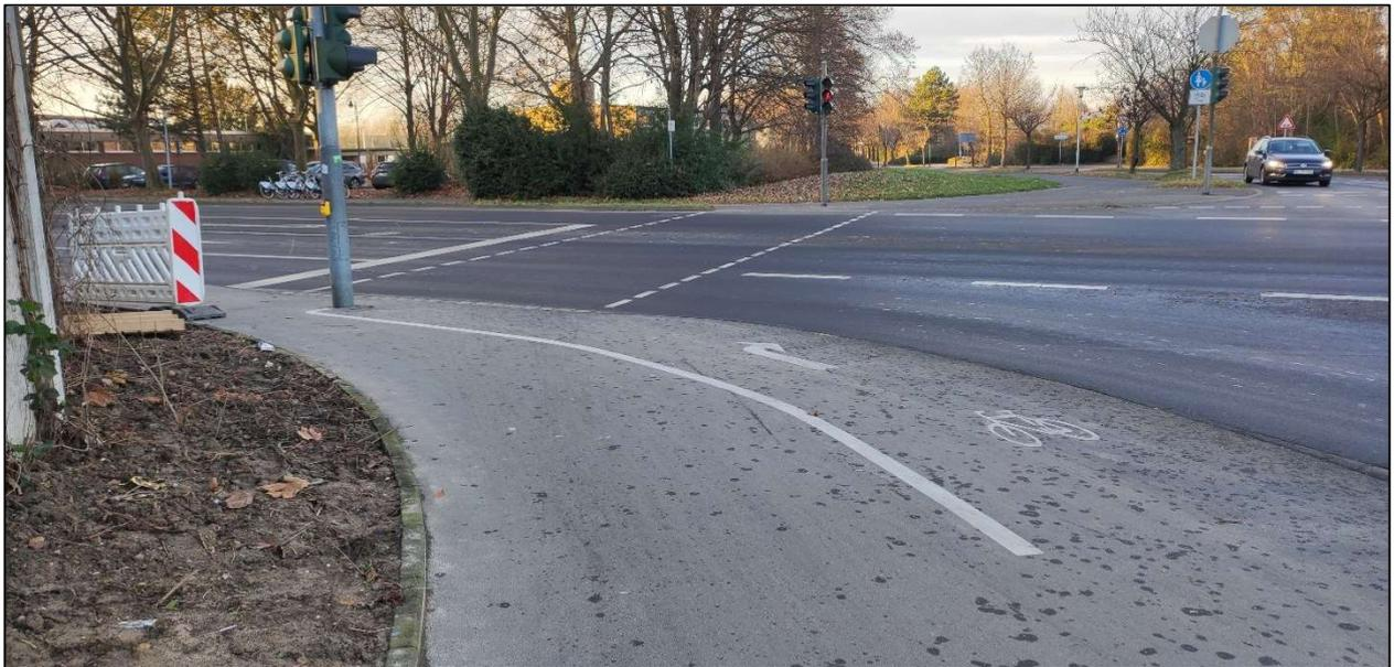
Abbildung 10: Radverkehrsführung im Bereich des Knotenpunkts Berliner Str. / Premnitzer Str. / Feldmühlestr., hier treten während der Hauptverkehrszeiten Konflikte auf, da die ausgewiesene Fläche nicht ausreicht
