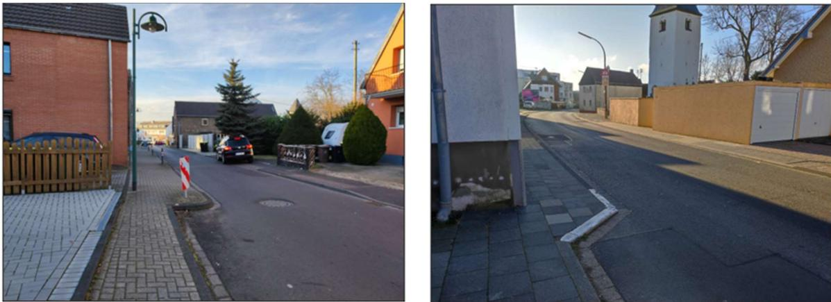
Abbildung 11: Schmale Fahrbahnen aufgrund von Verbreiterungen des Seitenraums in der Porzer Straße (l.) und der Wahner Straße (r.)
