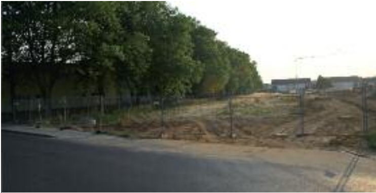
Hier entsteht eine neue Kita in der Käthe-Kollwitz-Straße in Lülsdorf.
